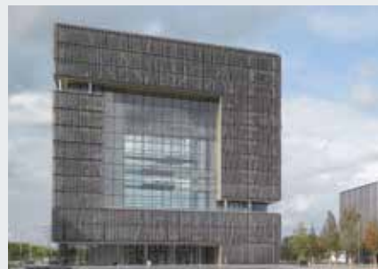
Главный офис компании ThyssenKrupp AG, Эссен
